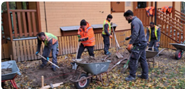
Algeco Dachs volunteering in Eitensheim.
